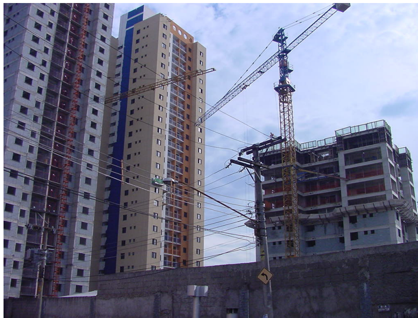
Figura 3.17 Vista do canteiro de obras – Estudo de Caso H
