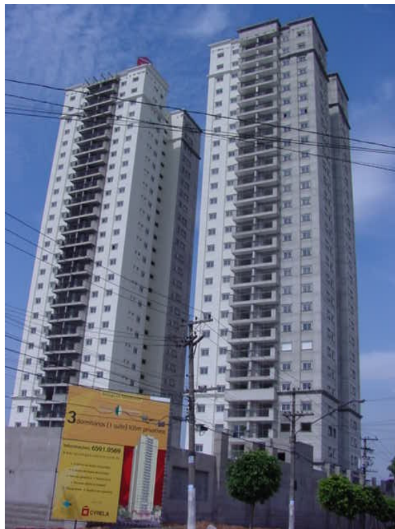
Figura 3.6 Vista lateral do canteiro de obras – Estudo de Caso D
